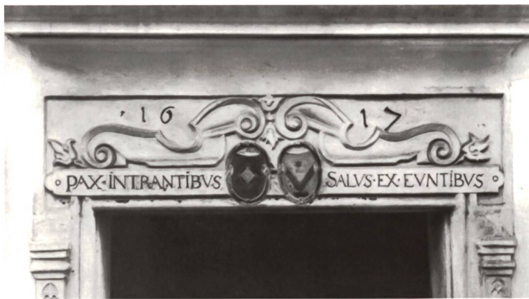
Abb. 8: Haus Kirchenstrasse 3 in Zug. Türgewände, vor der Versetzung im 20. Jahrhundert. Inschriftkartusche und in der Mitte die in den ovalen Scheiben gemalten Wappenschilder der Familien Speck und Landtwing, darüber Rollwerkgiebel und Jahreszahl. Zustand vor 1940.
