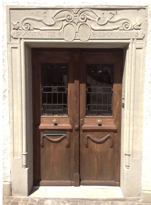
Abb. 7: Haus St.-Oswalds-Gasse 10 in Zug. Versetztes Türgewände des Hauses Kirchenstrasse 3. Türsturz in frühbarocker Manier mit Inschrift, Datierung 1617 und heute blinden Wappenscheiben. Zustand 2016.
