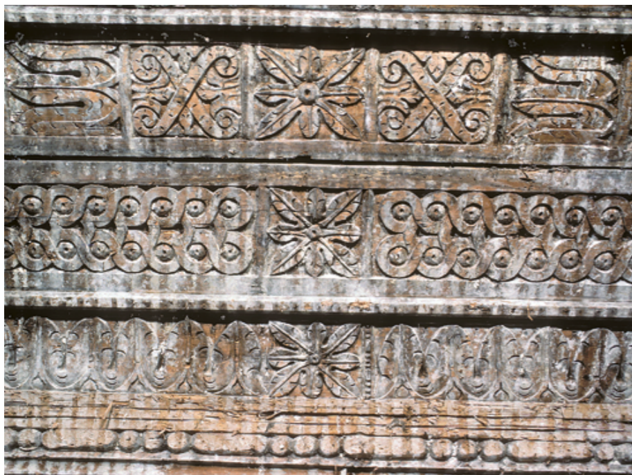
Fig. 32 Détail des planches de la voûte en berceau de 1626.
