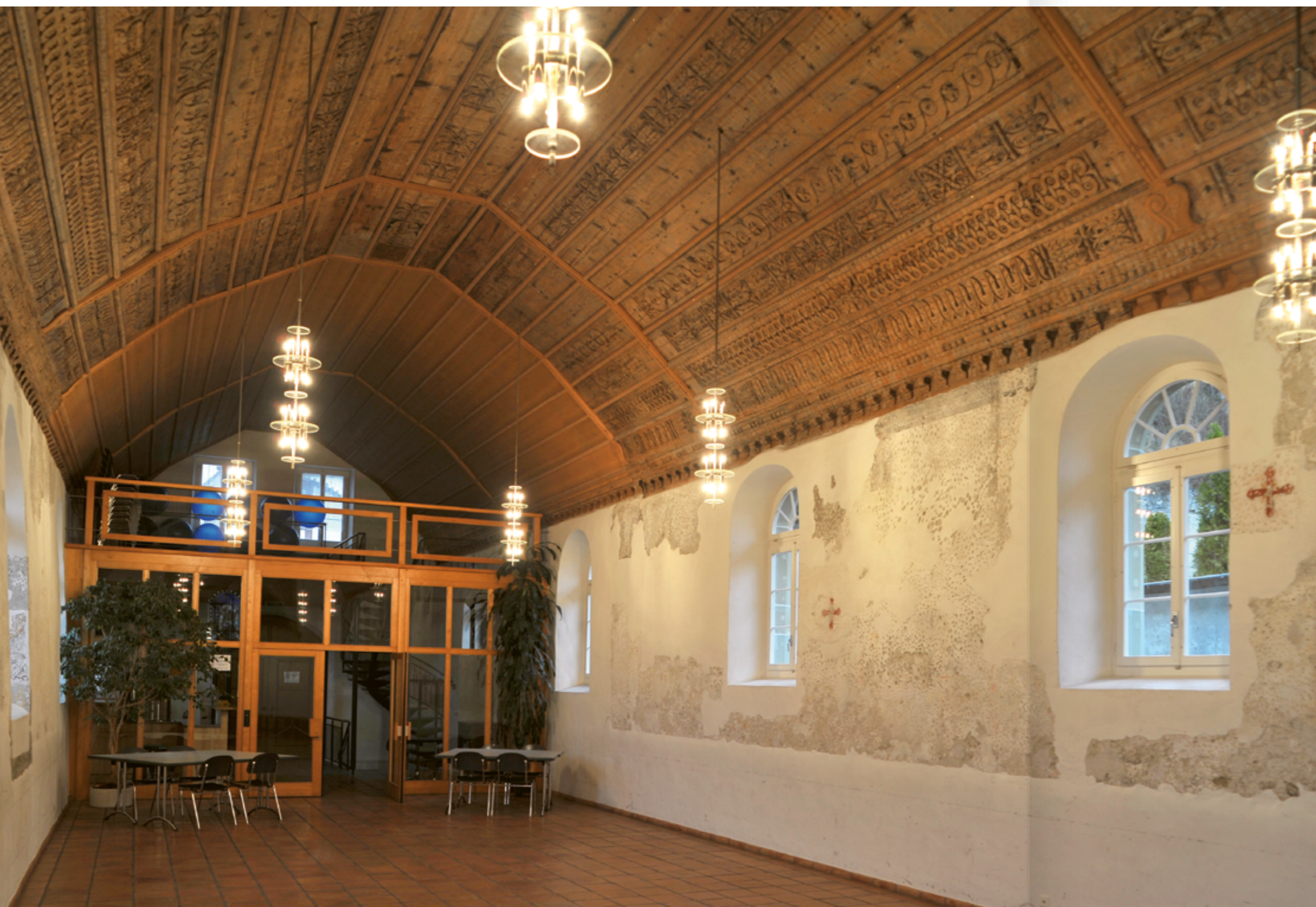
Fig. 39 Extrémité occidentale de la nef avec les limites bien visibles du plafond de la nef de 1626 et de ses allongements de 1743 et 1863.
