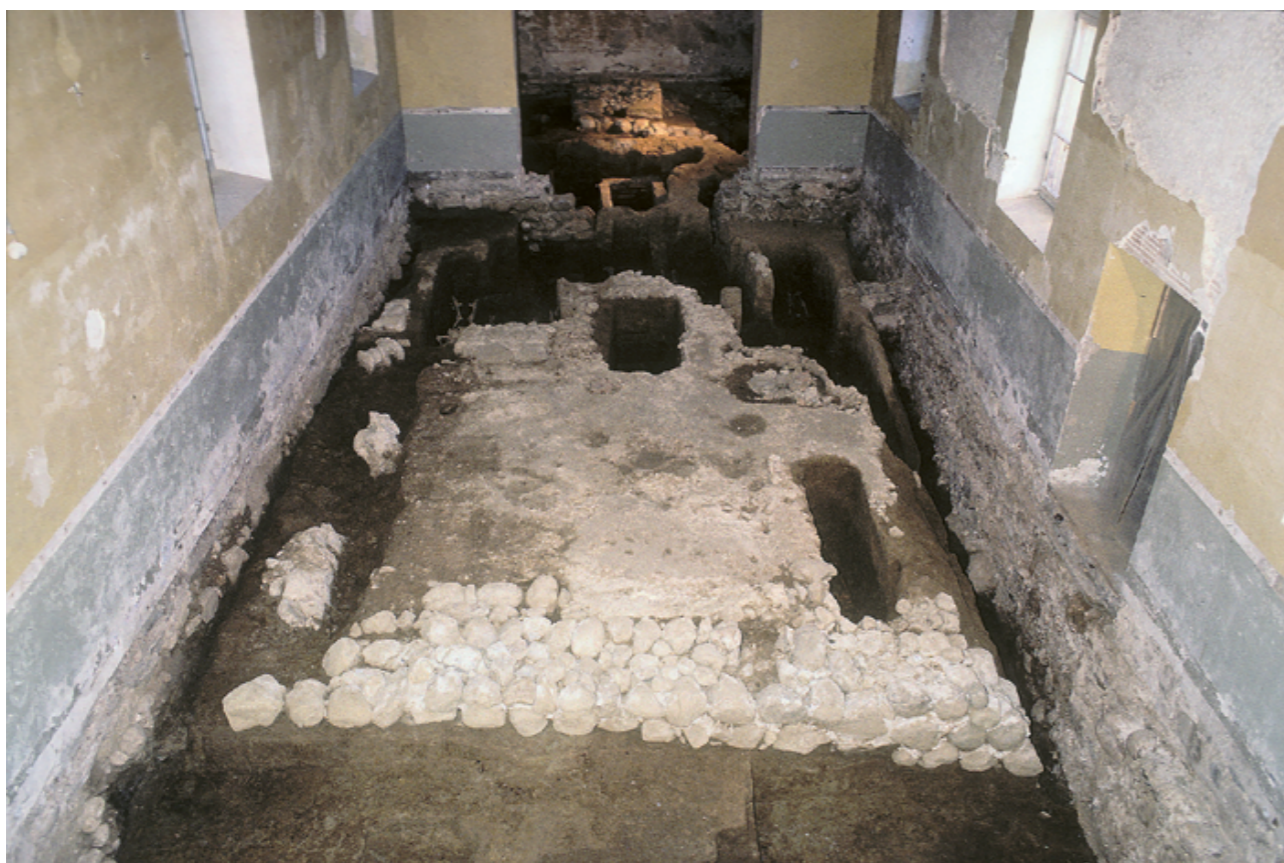
Fig. 5 Fondations et sol en mortier de la première église.
